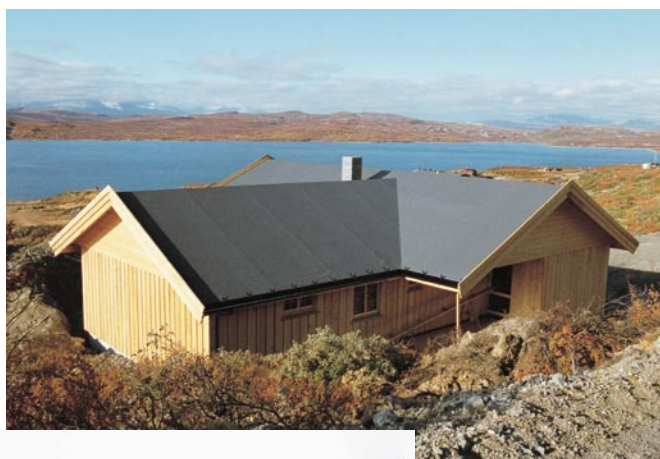
Ferdig tekket tak med Protan torvtaksmembran.
