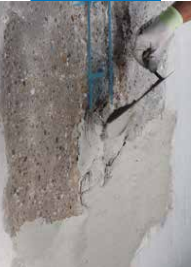
Påføring av Planitop Smooth & Repair med murskje
