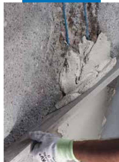
Utjevning av Planitop Smooth & Repair med en rett kant
