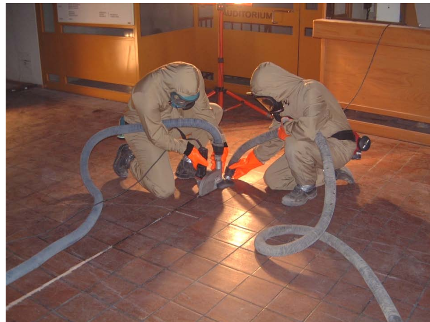
Sanering av PCB holdige fuger foto: Veolia. SINTEF Byggforsk kunnskapssystemer 700.802
