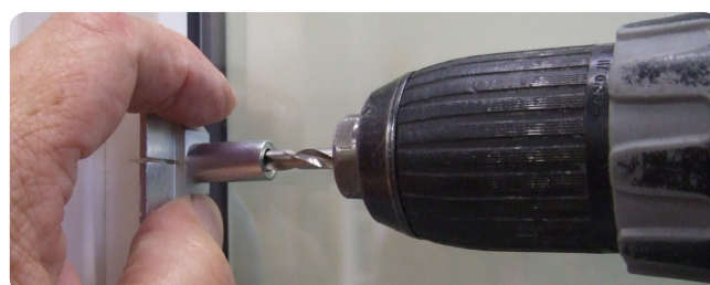
Figur 5 Boring av hull gjennom festet boremal
