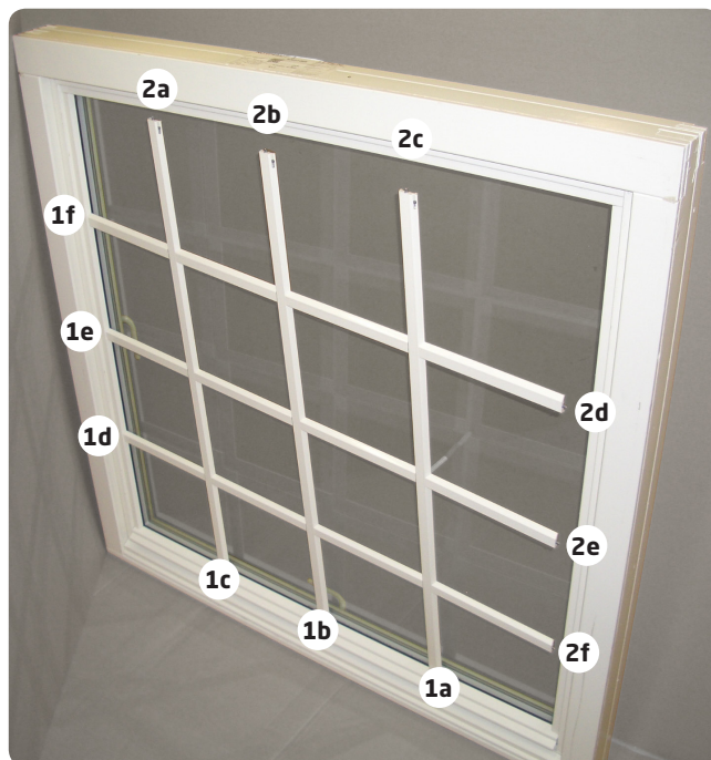
Figur 7 Rekkefølge for montering
