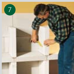
7 Plattan rättas till och sätts i vinkel
