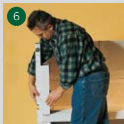
6 Plattan kontrolleras med vattenpass
