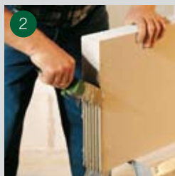
2 Limmet stryks på och jämnas ut med en limskopa
