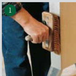
1 Limytan borstas och förvattnas
