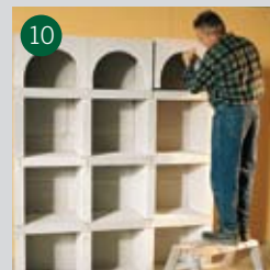
10 Såga till bågar och montera.
