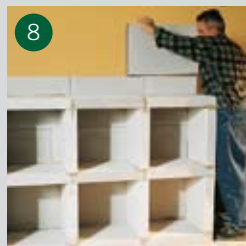
8 Nästa rad byggs upp
