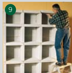
9 Taket sätts på
