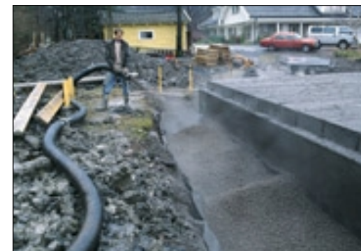
Sørg for god drenering rundt grunnmuren, så slipper du fuktproblemer senere!
