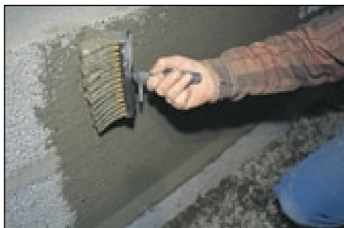
Enkleste overflatebehandling av grunnmuren er slemming.
