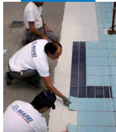
Legging av fliser med Mapelastic i svømmebassen
