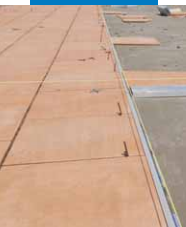
Legging av fliser med Kerabond + Isolastic
