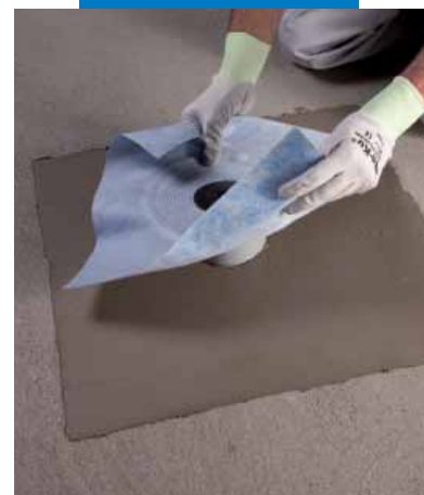
Installering av slukmansjett med Mapelastic
