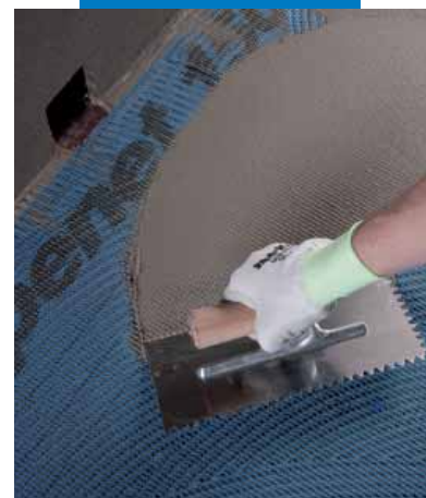
Påføring av Mapelastic over Mapenet 150
