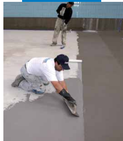
Vanntetting av svømmebasseng med Mapelastic
