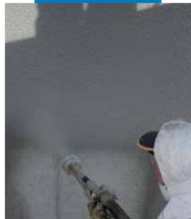
Påføring av Mapelastic med sprøyte på bru
