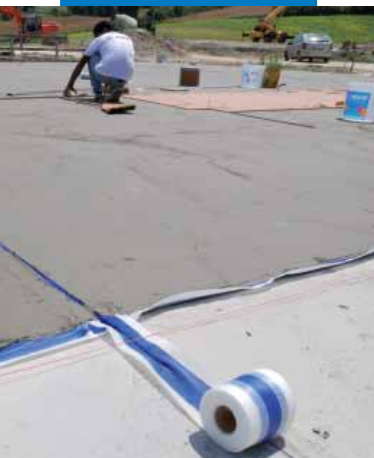
Vanntetting av underlag med Mapelastic og Mapeband
