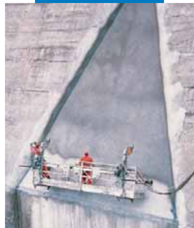
Påføring av Mapelastic med sprøyte på damanlegg
