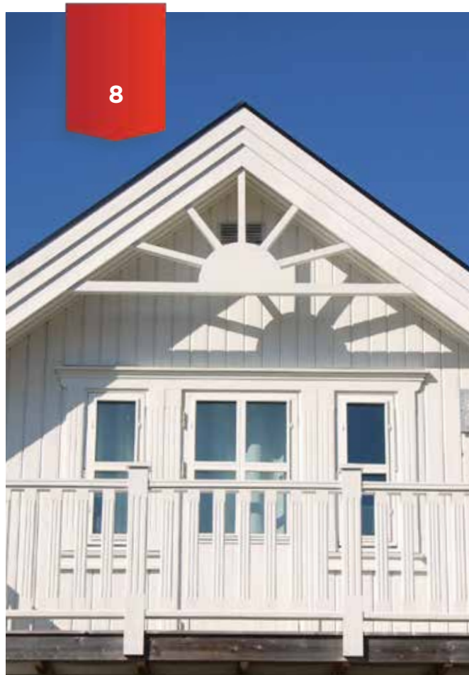
Bildet viser tilvalg Jens. Produktet er malt på byggeplass.
