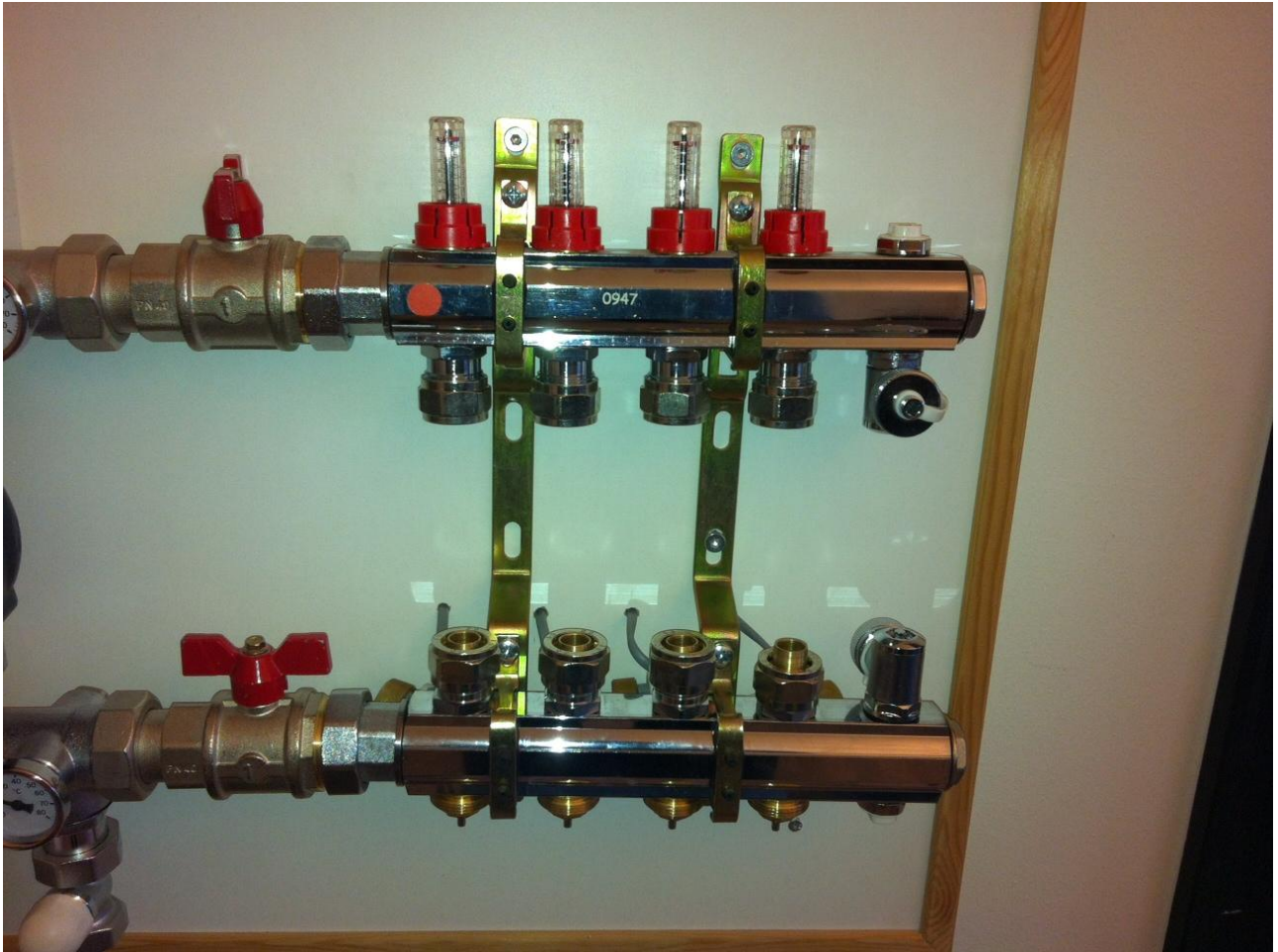
Fig. 4 Fordelerrør vendes (her har jeg kun vendt retur-fordelerrøret)
