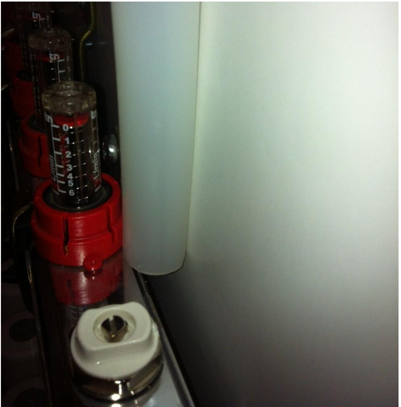
Fig. 6 Gulvvarmerøret er som udgangspunkt for tykt til at kan settes bak flowmetren. Det kan muligvis lade sig gøre ved at plassere fordeleren lidt ud fra veggen.
