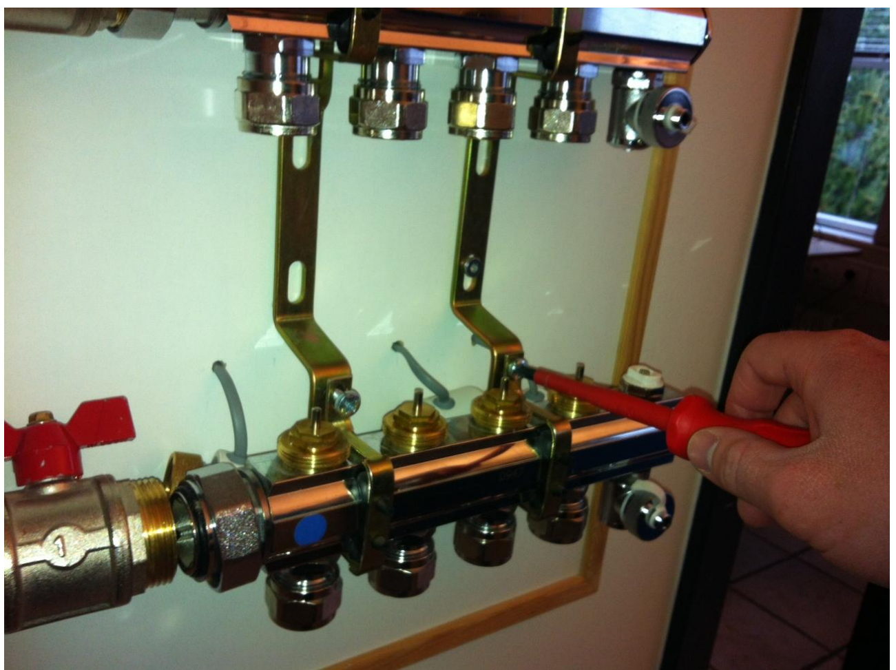
Fig. 2 Fordeleerrør løsnes (1)
