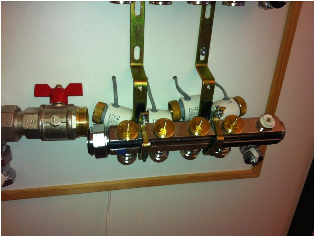
Fig. 3 Fordeleerrør løsnes (2)
