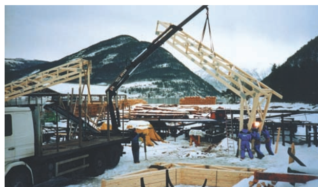
Figur 10.2 Konstruksjonene må ikke utsettes for uforutsatte belastninger under transport. Riktig stropping er viktig ved lastning, lossing og montering.
