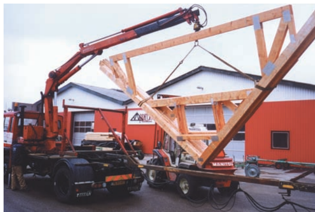
Figur 10.11 Stoppingen ved snuing av takstoler må gjøres riktig.
