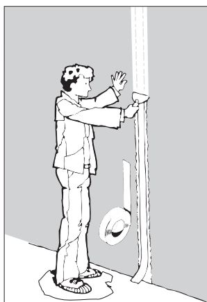
Stryk tapen fast i den våte massen. Strimmelen legges med utsiden av rullen inn på veggen.
