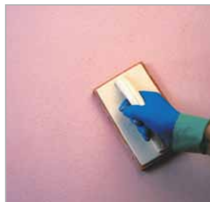
Fig. 5.19 – Avslutt topplaget med puss med et pussebrett med svamp
