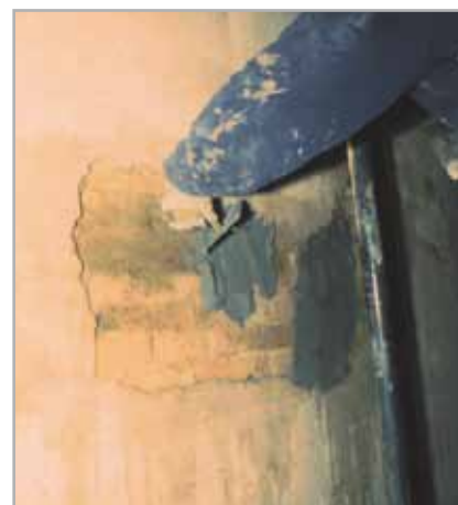
Fig. 5.5 - Utbedring av skadet område med rep. mørtel.
