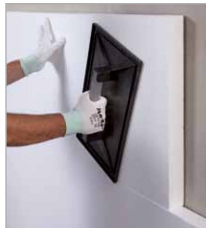
Fig. 5.11 – Press inn platen med et pussebrett
