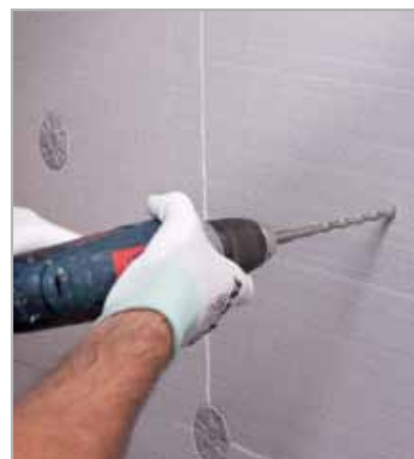
Fig. 5.12 – Bor hull til pluggene
