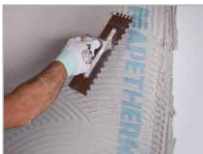
Fig. 5.16 – Legg på MAPETHERM NET
