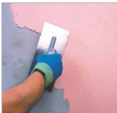
Fig. 5.18 – Påfør det avsluttende laget med puss
