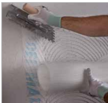
Fig. 5.17 – Overlapp kantene med nett med minst 10 cm
