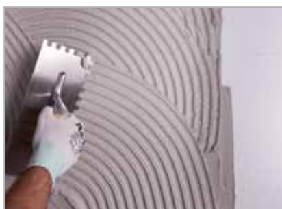
Fig. 5.15 – Påfør det første laget med glattende og ujevne masse
