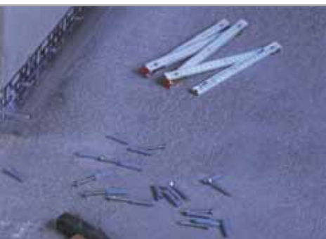
Fig. 5.7 – Fest profilen med ekspansjonsplugger
