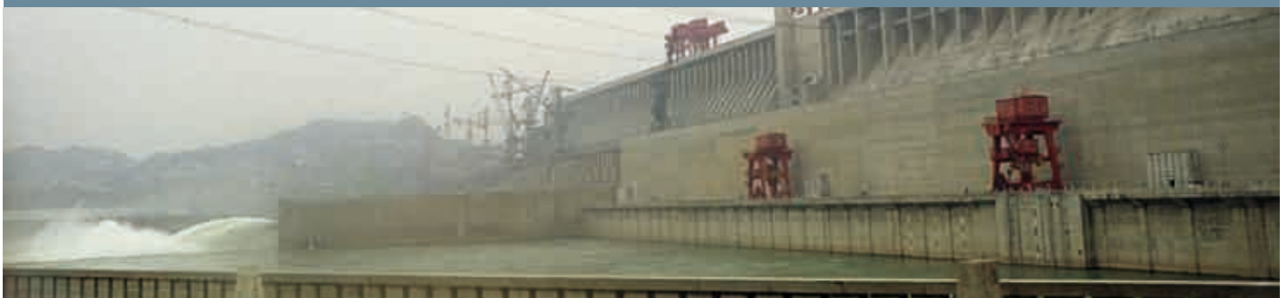
Three Gorges dam i Kina er verdens største damprosjekt
