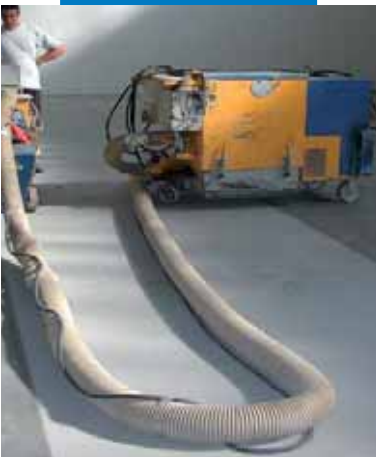
Klargjøring av underlaget ved hjelp av blastring
