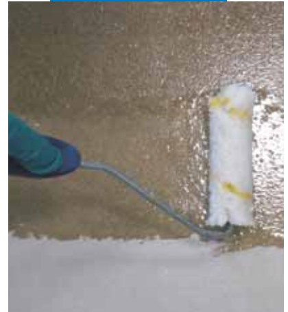
"Terrazzo alla veneziana" – påføring av Mapefloor I 910
