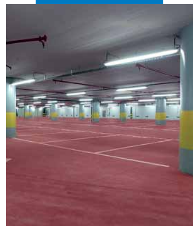
Gulv utført med rød Ultratop i Berlaymont bygningen i Brussel
