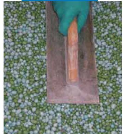
"Terrazzo alla veneziana" – påføring av blandingen Mapefloor I 910 og Dynastone Color
