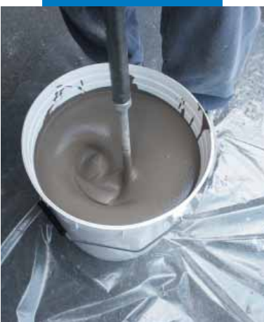
Klargjøring av blandingen med drill
