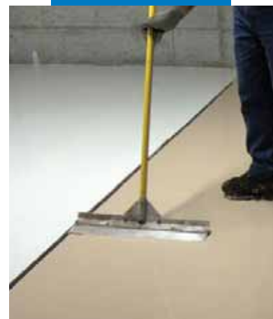
Utjevning av Ultratop umiddelbart etter påføring
