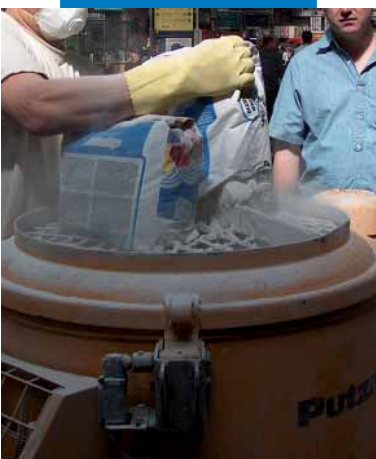
Klargjøring av Ultratop i mikser
