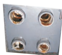
Vanntilkobling på baksiden av CBB Energisentral
