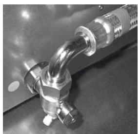
Tilkobling varmekrets-returløp (returvann) ved apparattyper med kjølefunksjon.
