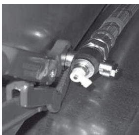
Tilkobling varmekrets-returløp (returvann) ved apparattyper uten kjølefunksjon.
