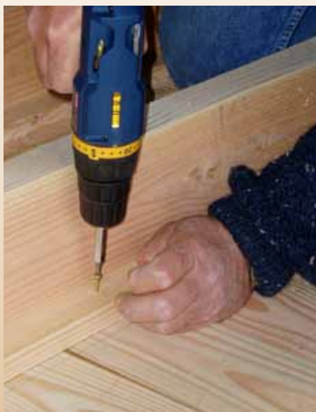
T-balkarna skruvas fast.
