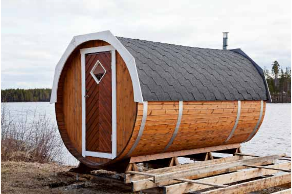
Den runda bastun stadigt uppställd i sina vaggor. Till höger är reglarna för altangolvet.
