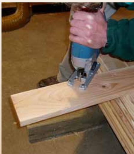
Fästbrädan kaapas efter den ritsade linjen.
