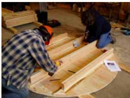
T-balkarna skruvas fast.
