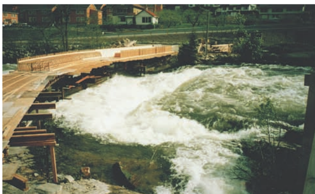
Figur 4.16.2 Spikerplatekonstruksjoner egner seg godt til forskalinger. Bildet til venstre viser eksempel på en bro-forskaling. Leverandør: Kaupanger Tre AS.
