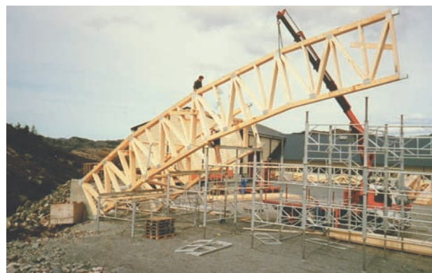
Figur 4.14 Buehall med spennvidde 80 m. Prøvekonstruksjon i halv størrelse under montering (kilde: Vest Tre AS).
