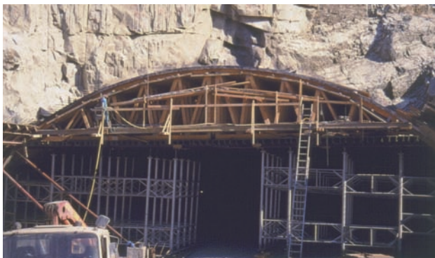
Figur 4.11 Forskaling til biloppstillingsplass – Mannheller. Leverandør: Kaupanger Tre AS.
