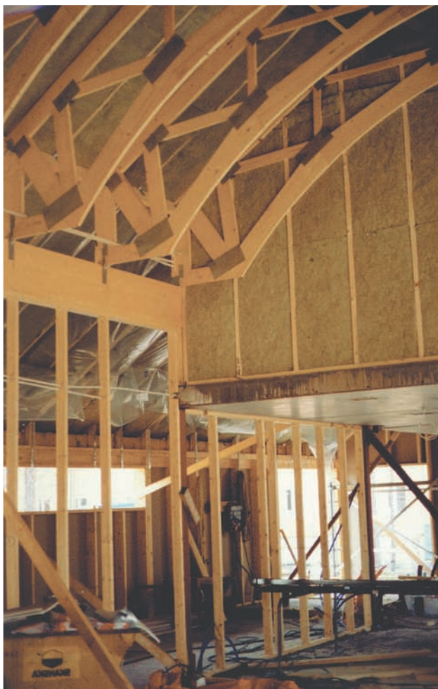
Figur 4.16.7 Buekonstruksjoner til Rena Leir. Leverandør: RingAlm Tre AS.
