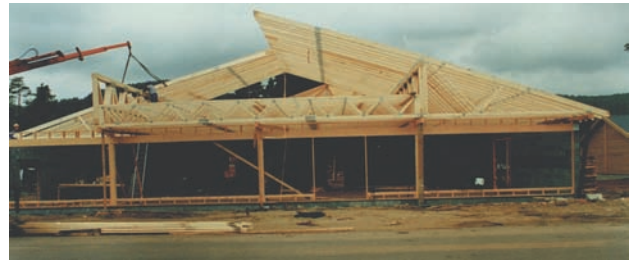
Figur 4.4 Gitterdragere som opplegg for pulttakstoler med forlenget overgurt. Det skal monteres limtretrager i mønet. Det er også gitterdragere i bjelkelaget (kilde: Nordisk Kartro AS).
