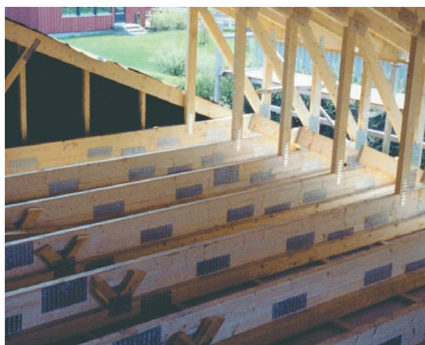
Figur 4.9 Her er en del av huset hevet for å gi plass til rom på loftet. Undergurtene i de gamle takstolene spikres til de nye. Resten av de gamle takstolene skjæres så vekk (kilde: Kaupanger Tre AS).
