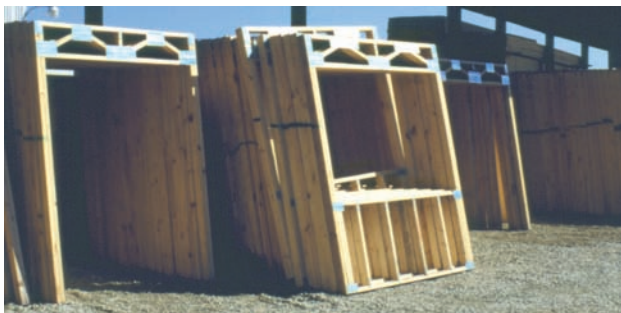
Figur 4.10 Gitterdragere brukt som overdekning ved store vinduer.
