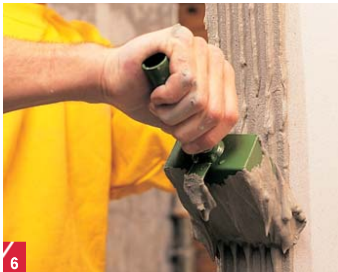
Børst limfladerne rene, vand dem godt, og træk limen på med en speciel limske. Tryk pladen på plads, og lad den "sætte sig".
