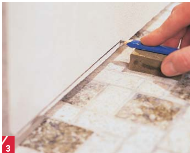
Overfør gulvets hældning til pladen ved hjælp af en afstandsklod, der er højere end største afstand mellem plade og gulv.
