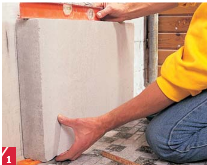
Stil de yderste plader ud for mærkerne. Ret op med kiler og vaterpas, så de står i lod og vage og i samme højde.
