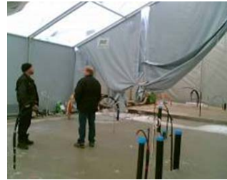
Figur 8.1 Bygging under telt gir god fuktsikkerhet
