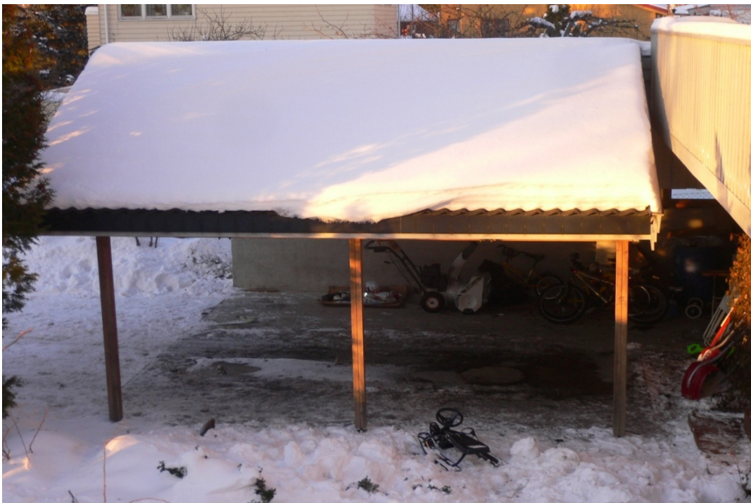
Figur2.7, Carport med bærende søyle i midten.
