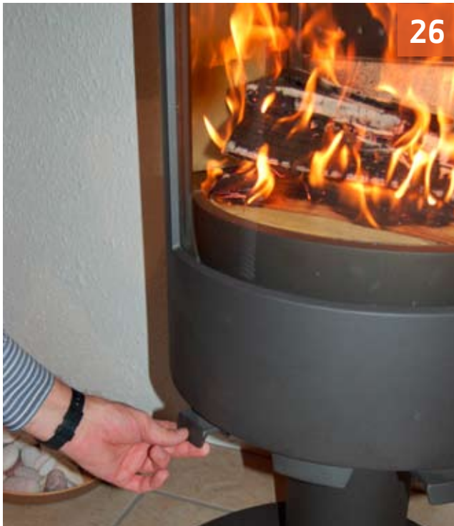
Bilde 26. Primærluftventil stengt etter 30 min.
