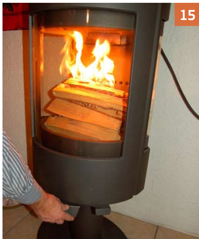
Bilde 15. Lukk døren dersom trekken tillater dette.
