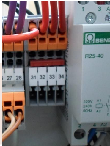
Bilde 6: Ved forbindelse mellom klemme 31 og de øvrige klemmer, kan temperatur i elkoble bli overstyrt av for eksempel varmepumpe.
