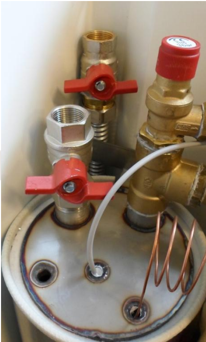
Bilde 1: Rørteknisk tilkobling av alternative varmekilder.
