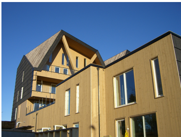
Figur 1.1 Norwegian Wood prosjektet Egenes Park i Stavanger. Boligene på Egenes skal ha et maksimalt levert energiforbruk på 75 kWh/m 2 år. Foto: SINTEF Byggforsk
