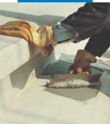
Påføring av Adesilex PG1 med tannsparkel for strukturell liming av støpte trinn
