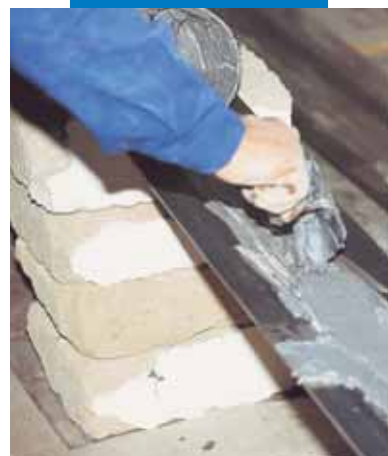
Montering av metallplate for strukturell forsterkning
