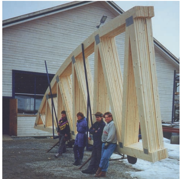
Figur 2.7.5 Tunnelforskaling i ventehall Mannheller. Leverandør: Kaupanger Tre AS.
