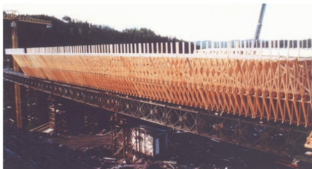
Figur 2.11.11 Broforskaling E18 i Sande. Leverandør: ECO Bygg AS/Naglestad Bruk AS.
