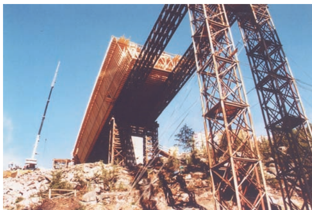
Figur 2.11.11 Broforskaling E18 i Sande. Leverandør: ECO Bygg AS/Naglestad Bruk AS.
