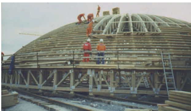
Figur 2.9 Forskaling til Trollplattformen, buede gitterdragere (kilde: NTI).
