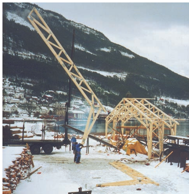
Figur 2.11.2 Industribygg. Gitterrammer og vindfagverk. Leverandør: Kaupanger Tre AS.
