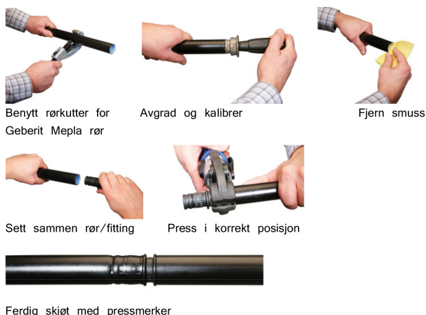
Ferdig skjøt med pressmerker
