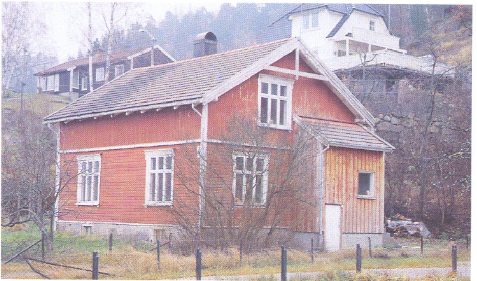
Nøddingstykket I, Vennesla. Ti arbeiderboliger oppført 1908, som horisontaldelte tomannsboliger (Vigeland Bruk). Hver leilighet har 2 rom + kjøkken. Privet i tilbygg. Laftet tømmervegg, pløyd fasanel og sementtakstein. DAA
