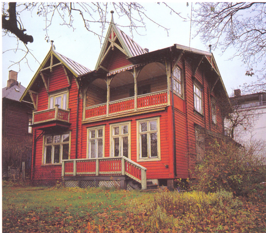
Nordraaks gt. 17, Frogner, Oslo, oppført 1892 etter tegning av arkitekt E. Johnsen. Asymmetrisk fasade med gavlmotiv og inntrukket loggia i 2. etasje. JT
