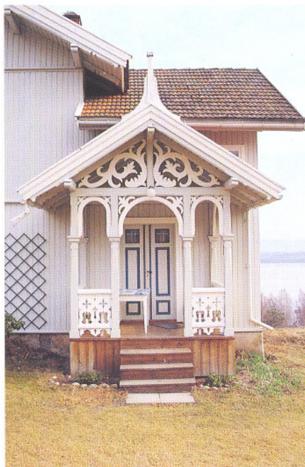
Eggehaugen, Ringerike, stuehus i sveitserstil typisk for østlandsbygdene, rikt dekorert inngangsportal, tidlig 1900. DAA
