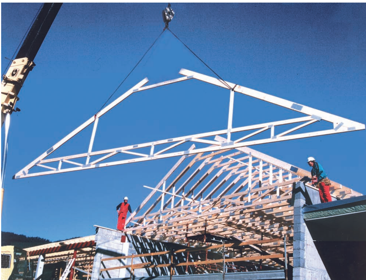
Figur 1.1 Konstruksjoner under montering. Leverandør: Kaupanger Tre AS.
