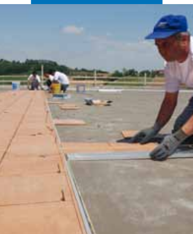
Legging av keramiske fliser med Kerabond + Isolastic
