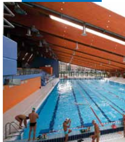
Svømmebasseng vanntettet med Mapelastic: Scarioni fritidssenter - Milano - Italia
