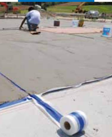
Vanntetting av underlag med Mapelastic og Mapeband
