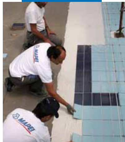
Legging av keramiske fliser på Mapelastic i svømmebasseng
