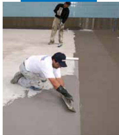
Vanntetting av svømmebasseng med Mapelastic
