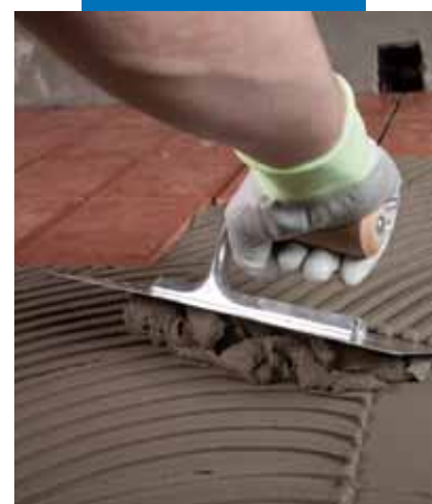
Påføring av Elastorapid på terrasse vanntettet med Mapelastic
