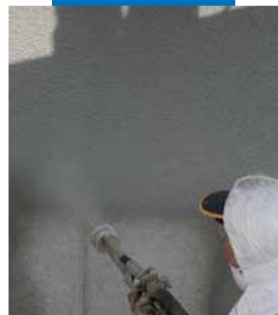
Eksempel på Mapelastic som påføres med sprøyte på bru
