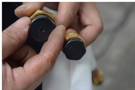
Podłącz rury z zestawu montażowego do przyłączy na jednostce wewnętrznej. Najpierw skręć połączenia śrubowe ręcznie, a następnie dokręć przy pomocy kluczy. Dokręć połączenie bez robienia przerw. Może być słyszalne syczenie. Przytrzymaj przyłączy jednym kluczem i dokręć nakrętkę złączkową drugim kluczem.
