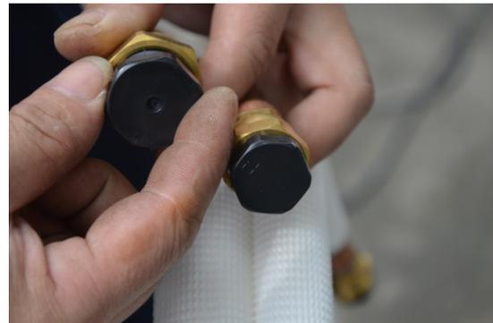
Anslut installationssatsens rör till anslutningarna på inomhusenheten. Skruva först ihop skruvanslutningarna för hand och dra sedan åt med skruvnycklarna. Dra åt anslutningen helt utan att göra uppehåll. Ett väsende ljud kan höras. Håll fast anslutningen med en skruvnyckel och dra åt överfallsmuttern med den andra.
