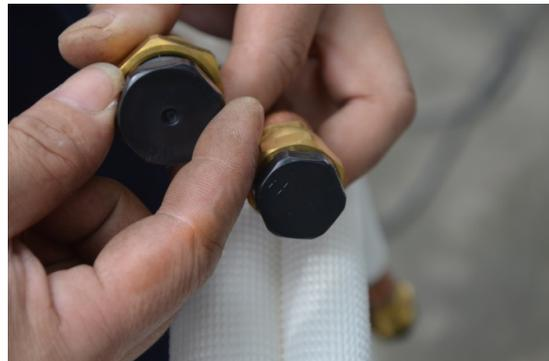
Koble rørene i installasjonssettet til tilkoblingene på innedelen. Skru først sammen skruetilkoblingene for hånd og trekk deretter til med skrunøkklene. Stram tilkoblingen helt uten å stanse. Da høres en hvesende lyd. Hold fast tilkoblingen med en skrunøkkel og stram til overfallsmutteren med den andre.
