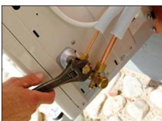
34. Skruva av muttrarna till vättskerören. Bakom dessa muttrar finns kranarna där ni skall släppa på gasen.
