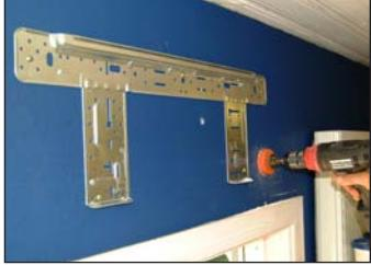
5. Borra hål i väggen. 65-70 mm. Obs! Borra hålet med lite fall mot utsidan pga att dräneringsslängens vattenflöde
