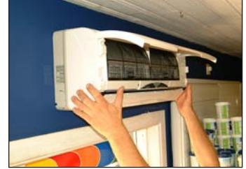
8. Föra ut rör-och strömkabelpaketet genom hålet och häng upp inndeelen. Nu är den på plats!
