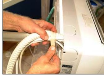
7. Tejp ihop rör - och strömkablar. Då blir det enklare att föra paketet genom det borrade hålet.
