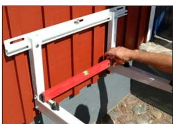
17. Väg in konsollen med vattenpass. Borra och skruva därefter fast de två andra fästsprutarna.
