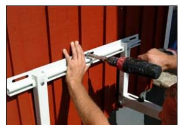
16. Skruva fast mittenskruven. Använd lämpliga fästsprutor när ni monterar er konsoll.
