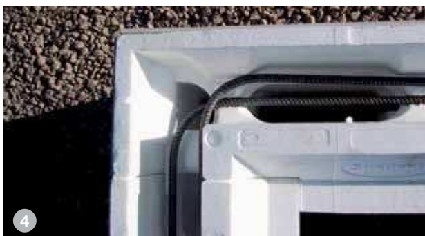
4 12 mm kamstål med lengde 90-100 cm bøyes i 90 grader og benyttes oppe og nede i hjørner.
