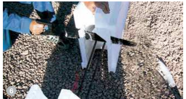
6 Når elementer må tilpasses er det nødvendig å skjære bort deler av låsesystemet.
