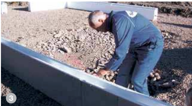
3 Når not og fjær systemet ikke kan benyttes i forbindelse med tilpasning, bruker en de vedlagte elementlåsene (bilde t.h.).
