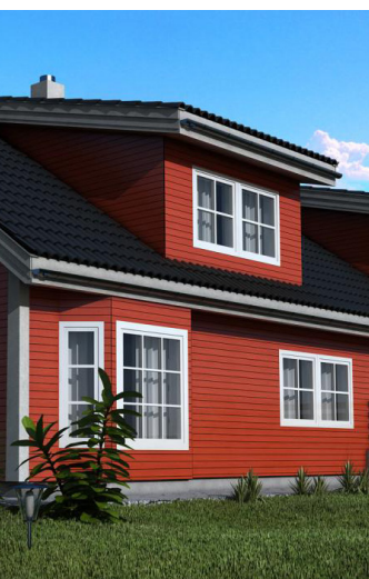
Hus med karnapp og takopplett
