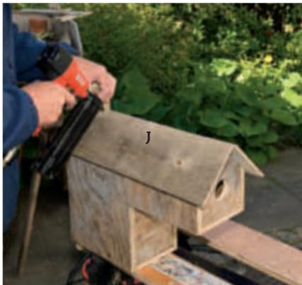
**5** Takplatene (J) stiftes fast med små klammer i pistolen eller med små stifter og en hammer. Vær forsiktig, det er ikke mye plass i ei plate på 6 mm.
